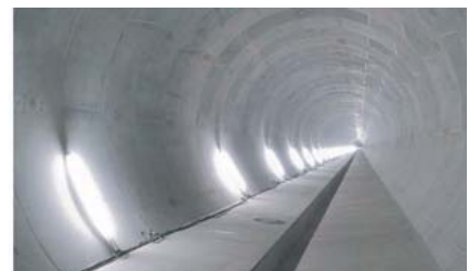
地下の雨水貯留施設
