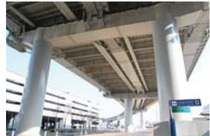
耐震補強済高架道路
