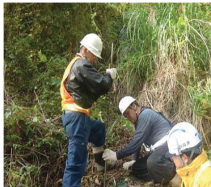
のり面地質調査状況
