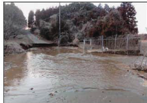
3号排泥工 出水状況
