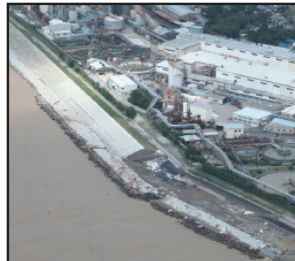
三重県紀宝町矢測地区の堤防整備
