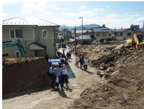
道路啓開作業(現場監督)
