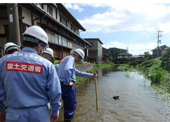
漏水調査の実施(中浜地区)
