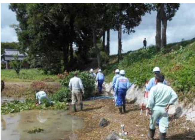
漏水調査の実施(大浜地区)
