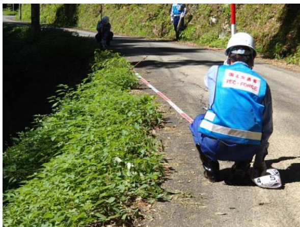
道路被災箇所への調査(志賀郷地区)
