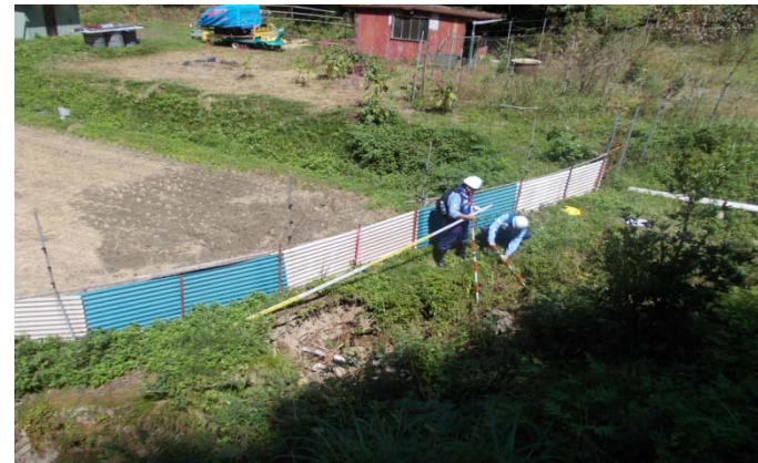
被災状況調査
