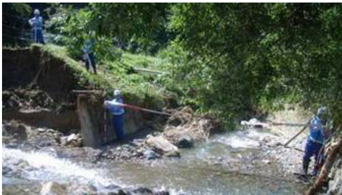
道路擁壁の被災箇所の調査
