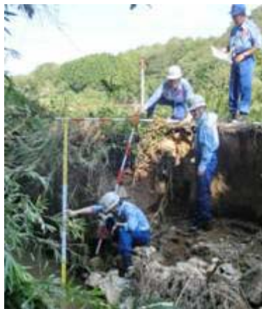
河川被災箇所の調査
