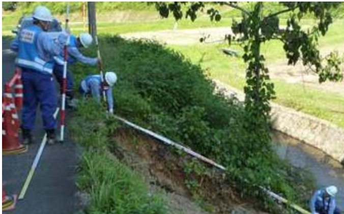
法面被災箇所の調査
