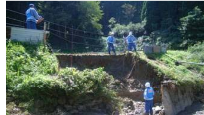
道路擁壁の被災箇所の調査
