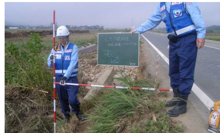
道路被災状況調査(福知山市域他)
