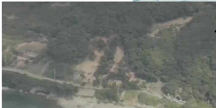
土砂崩れにより県道を寸断
