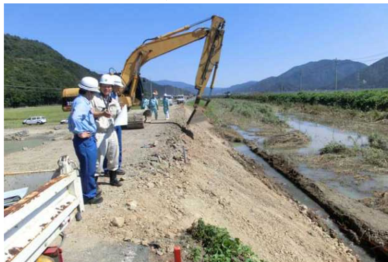
野木川破堤箇所の復旧について技術指導
