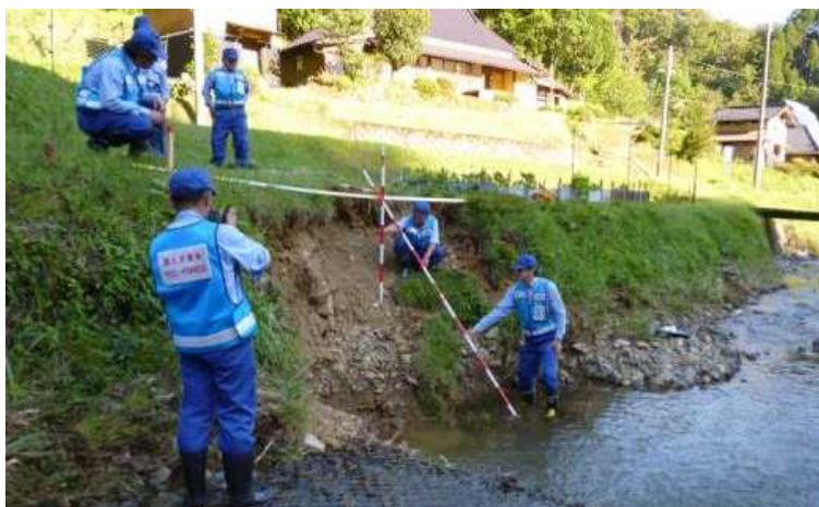
法面被災箇所の調査
