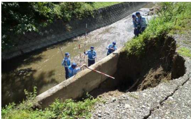
河川護岸の被災箇所の調査
