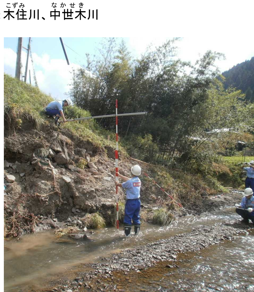
被災状況調査 (中世木川)
