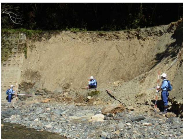
被災状況調査(加河川)
