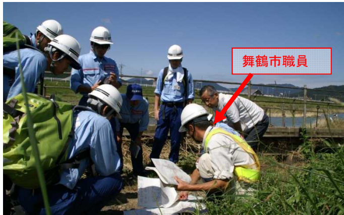
被災現場での状況確認(境谷橋)
