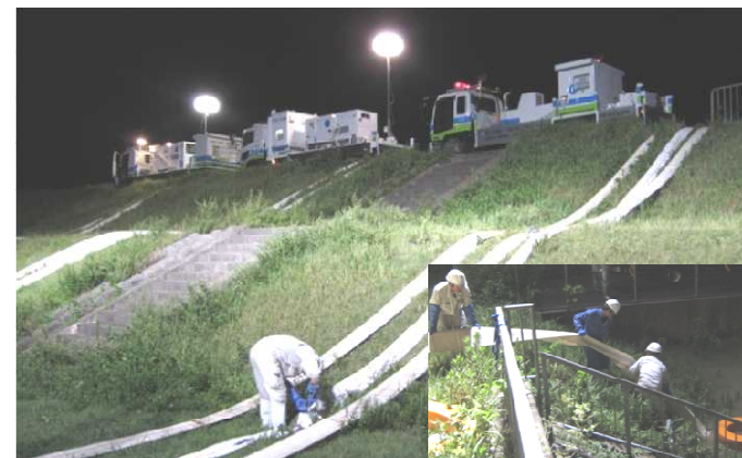
排水作業状況(福知山市荒河東町地区)
