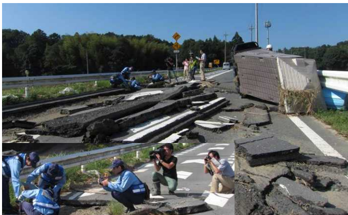
道路被災状況調査(福知山市前田地内)
