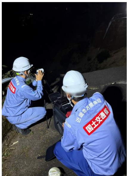
貸与機材の設置作業風景
