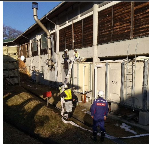
【給水班】能登町 作業状況（30日）
