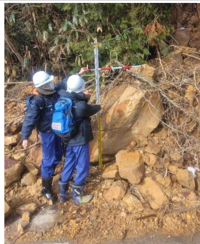
【砂防班】珠洲市 作業状況（30日）
