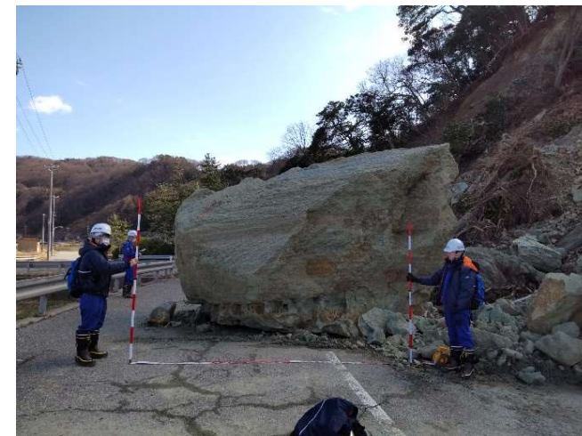
【道路班】珠洲市 作業状況（30日）
