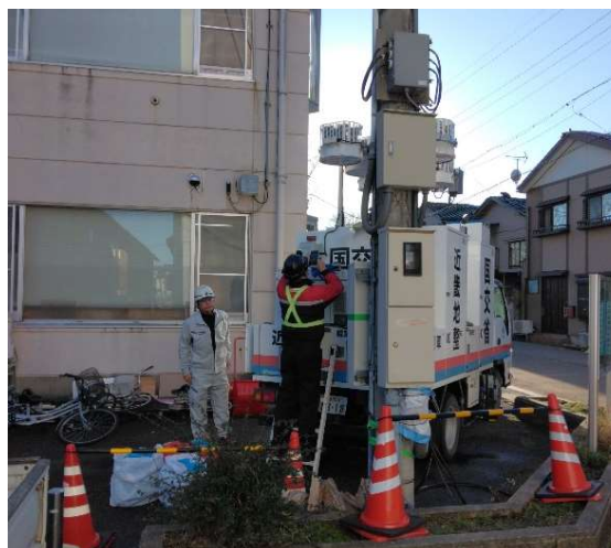
【電源支援班】輪島市 作業状況（17日）
