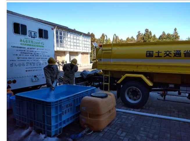
【給水班】能登町 作業状況（17日）
