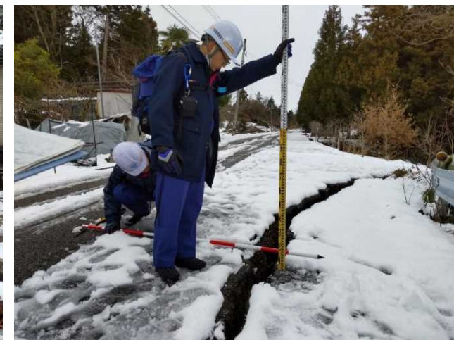
【市町道調査班】珠洲市 作業状況（9日）
