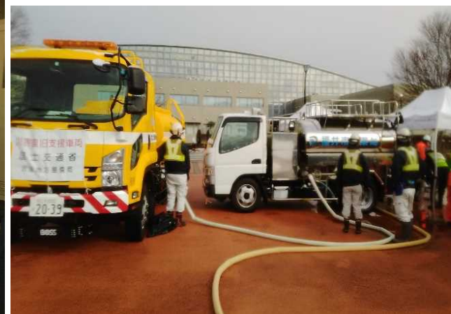
【給水班】中能登町 作業状況（9日）
