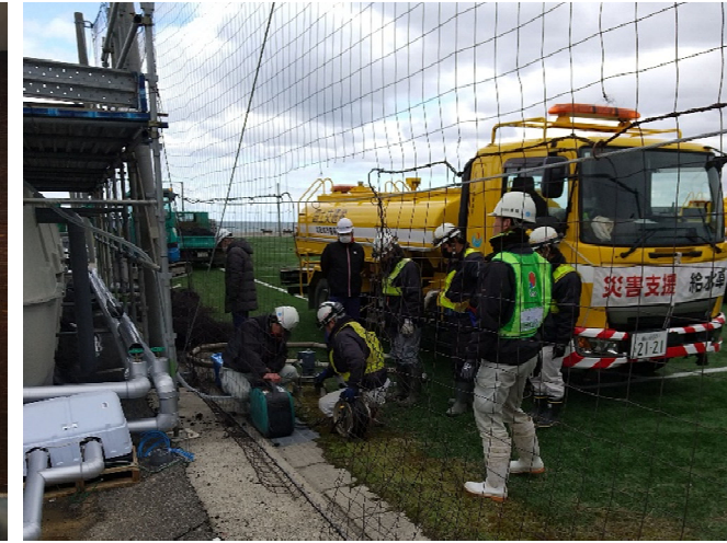
【給水班】輪島市 給水状況（26日）
