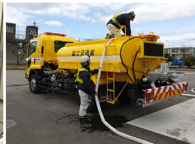
【給水班】金沢市 補水作業（24日）
