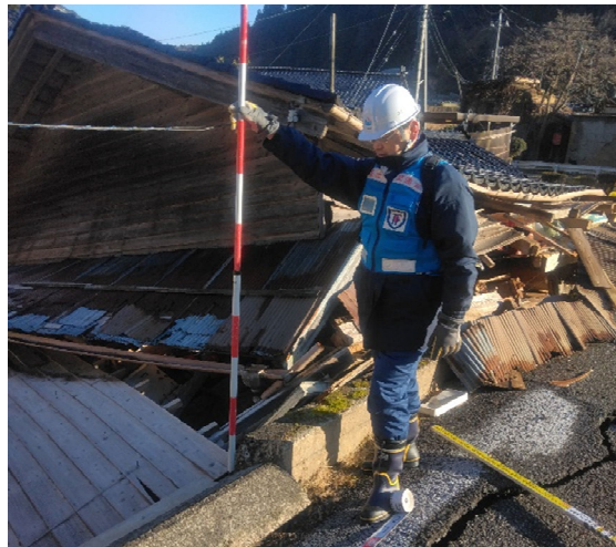
【道路班】輪島市 被災状況調査（13日）
