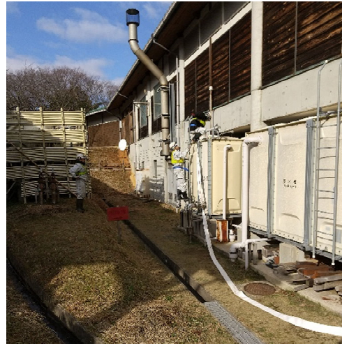
【給水班】能登町 給水状況（3日）
