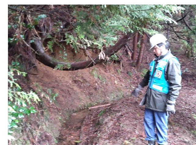
【水道班】穴水町 作業状況(22日)
