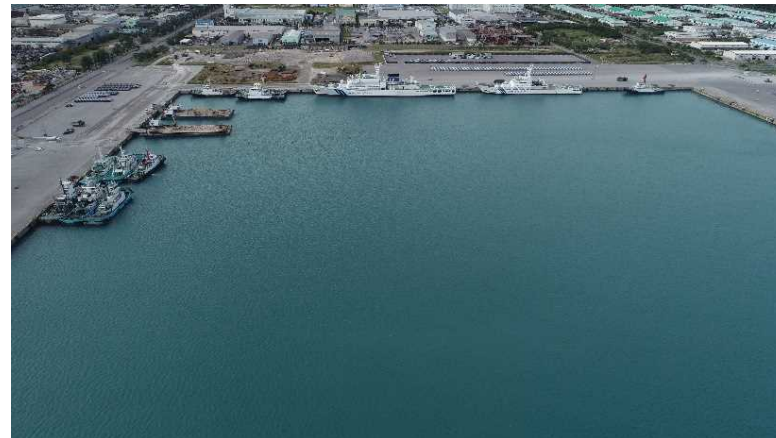
【中城湾港新港地区東ふ頭の状況】
