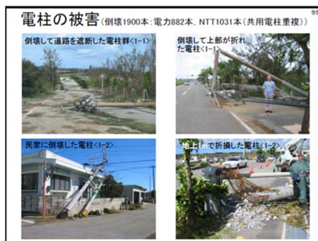
図 1.2.3 電柱の被害
