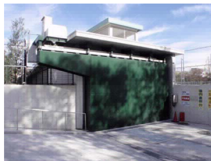
図3 泉尾配水場の防潮扉
