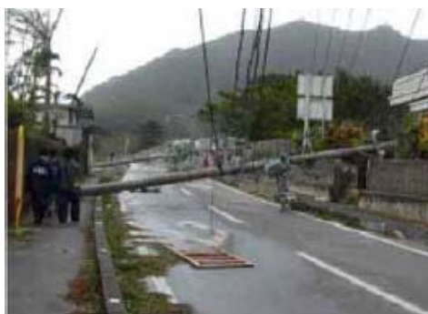
写真 3.2.1 台風による電柱の倒壊
