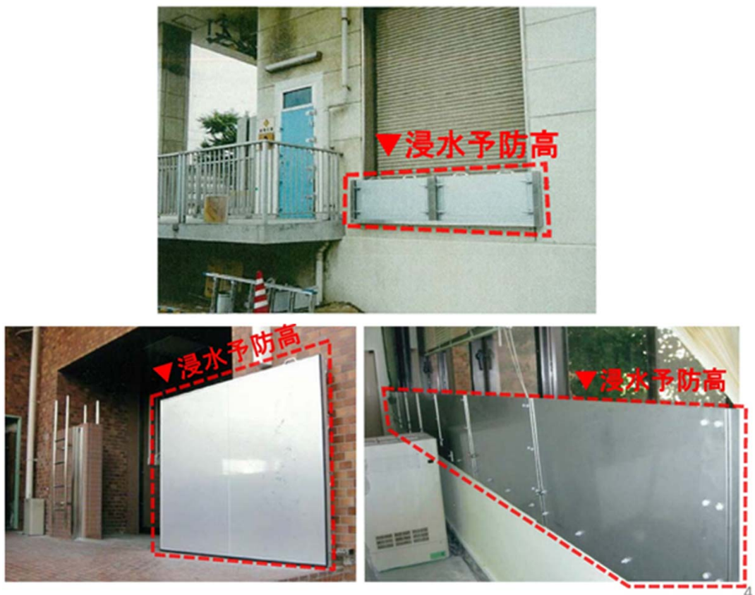
図1 ポンプ施設対策化の事例
