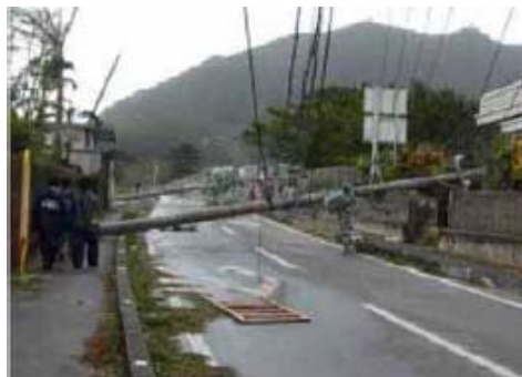
写真 3.2.1 台風による電柱の倒壊
