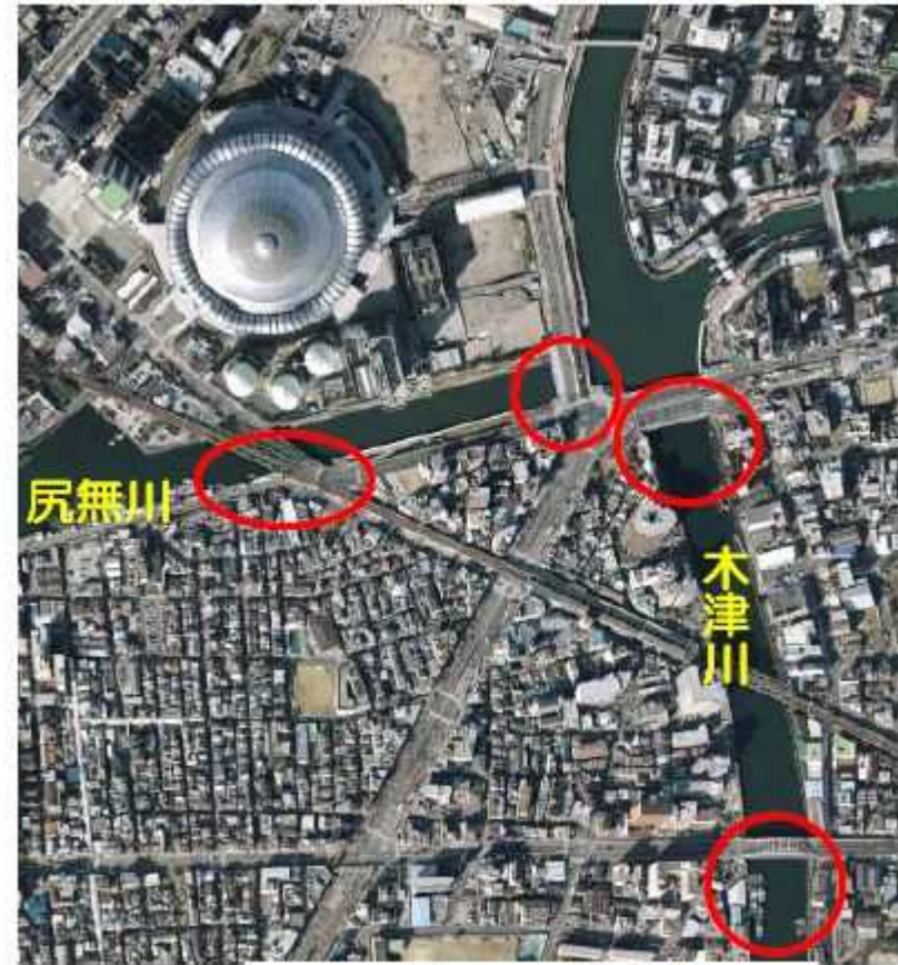
区外への脱出橋
