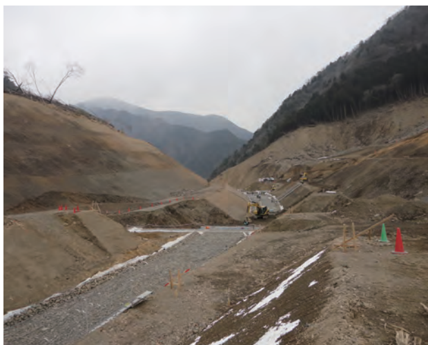
仮排水路施工中(24年2月1日)
