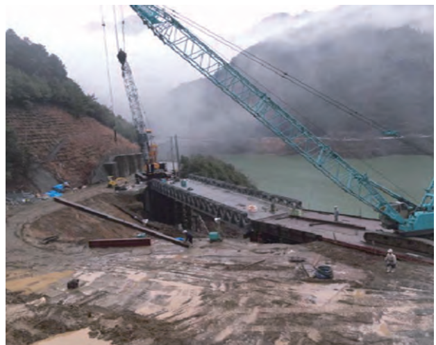
応急組立橋の架設(24年3月5日)
