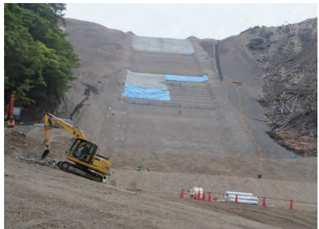
仮排水路の施工(24年5月24日)
