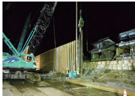
鋼矢板の打ち込み(9月24日)
