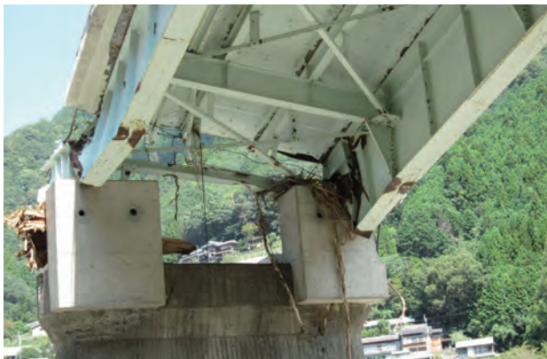
P1橋脚上の主桁
