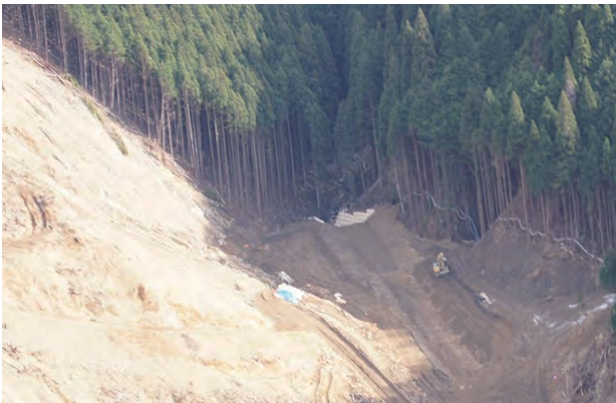
湛水池の埋め戻し(12月20日)
