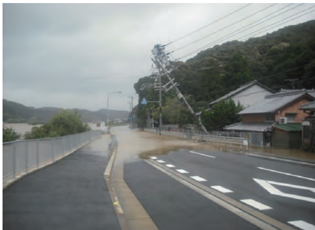
路面冠水(9月4日)南側から
