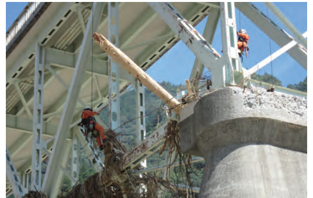
トラス桁の調査
