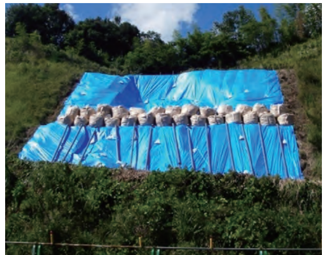
応急復旧(9月5日)
