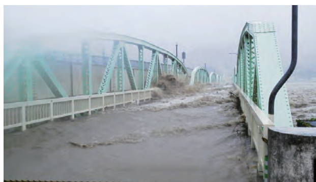
②(旧)熊野大橋からの越水(右岸)(9月4日6時頃)
