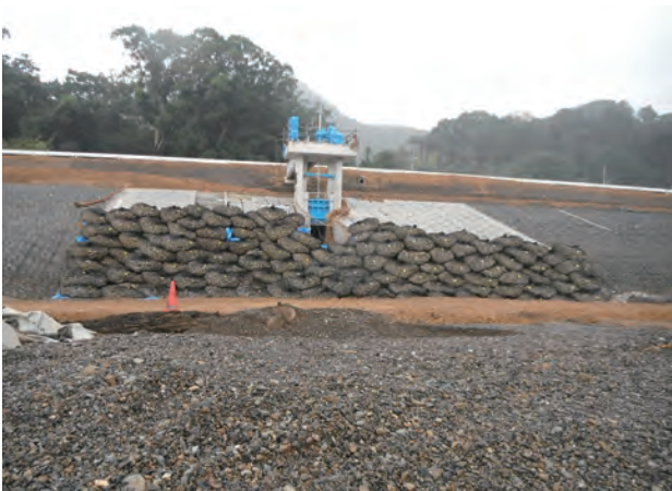
緊急復旧後(9月16日)
