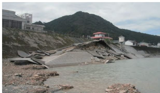
③新宮市船町地区 護岸損傷(9月5日)
