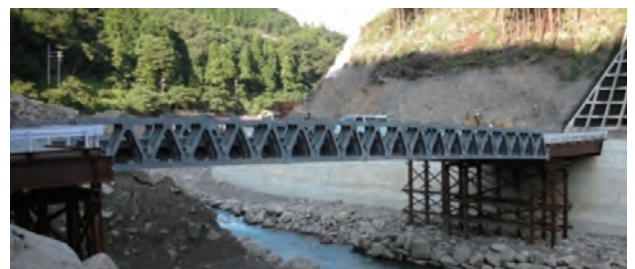
対岸への応急組立橋(24年9月)
