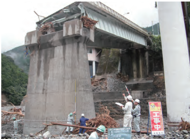
工事着手(9月16日)
