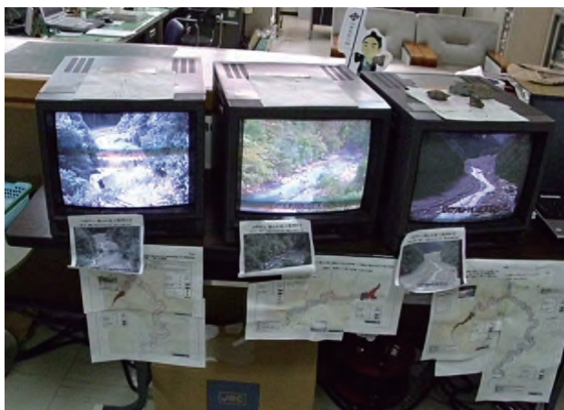
河道閉塞箇所の映像(十津川村役場)
