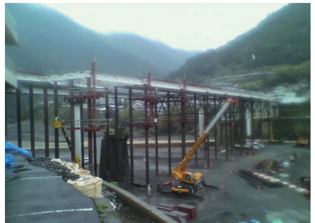
応急工事中の折立橋(10月22日)
