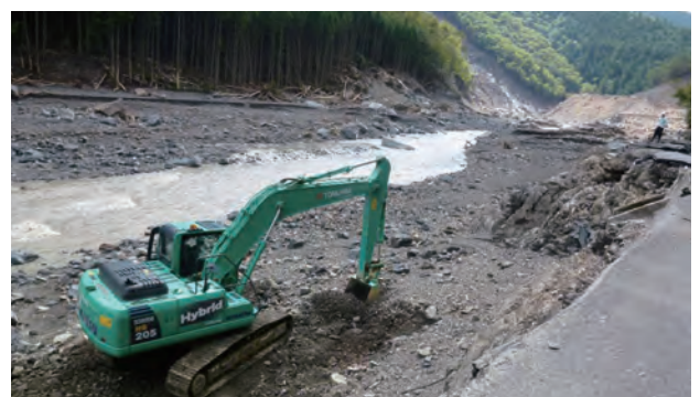
県道高野辻堂線の仮復旧(9月18日)
