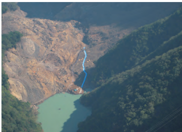
ポンプ排水(10月8日)
