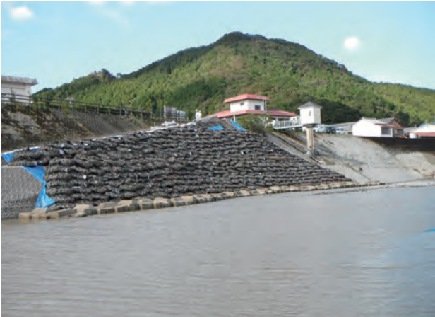
緊急復旧後(9月22日)
