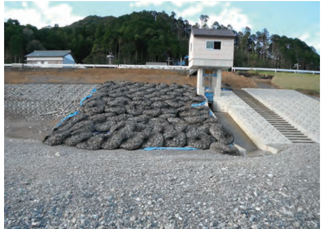
緊急復旧後(9月22日)
