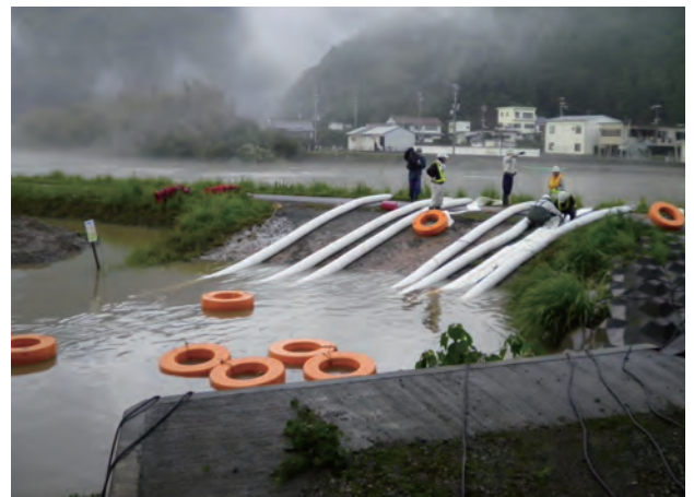
鮎田地先での排水作業(内水を相野谷川へ排水、9月4日)
