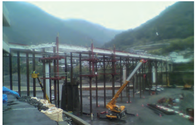
栈橋架設(10月24日)
