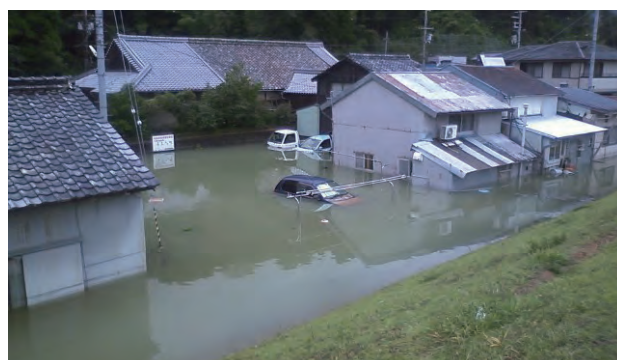
④新宮市相筋地区 浸水(9月4日11時頃)
