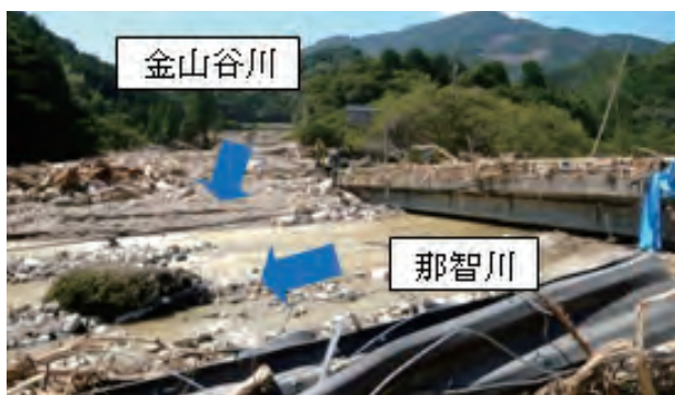
那智川水系金山谷川の土石流状況
