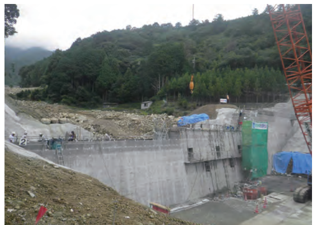
金山谷川砂防堰堤工事
