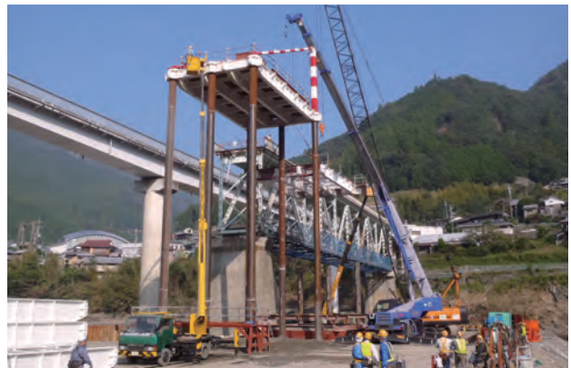
栈橋架設(10月9日)
