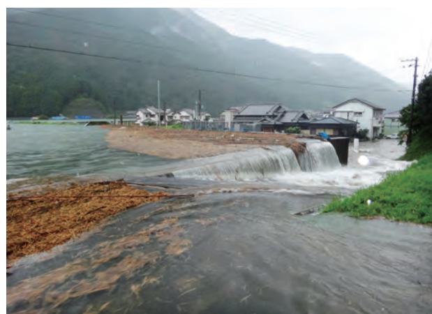
高岡地区輪中堤の越水(紀宝町提供、9月3日17時頃)
