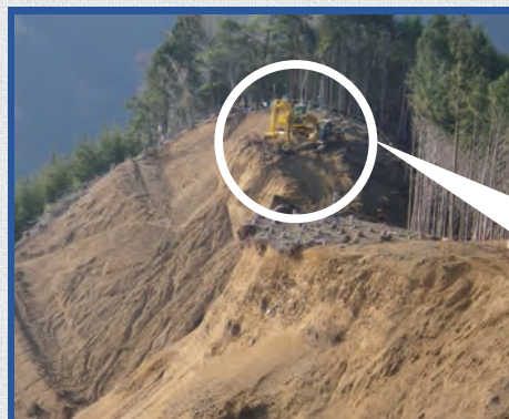
1km先の建設機械4台を遠隔操作
