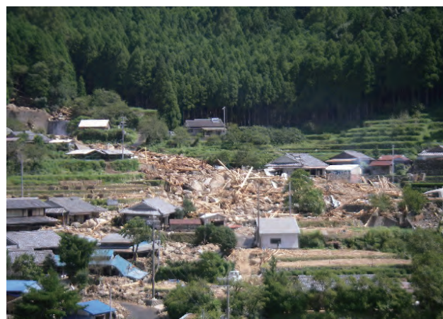
那智勝浦町口色川の土石流被害(9月8日)
