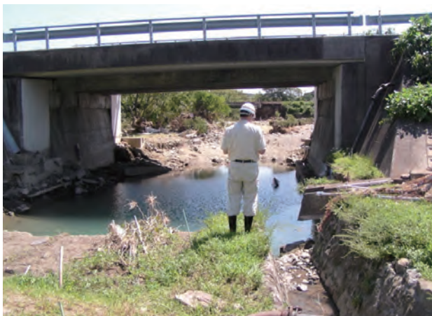
下里小橋の点検(9月5日)
