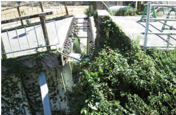
A1橋台上の伸縮継手部
