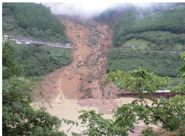
奈良県川上村迫(土砂崩壊、9月5日)
