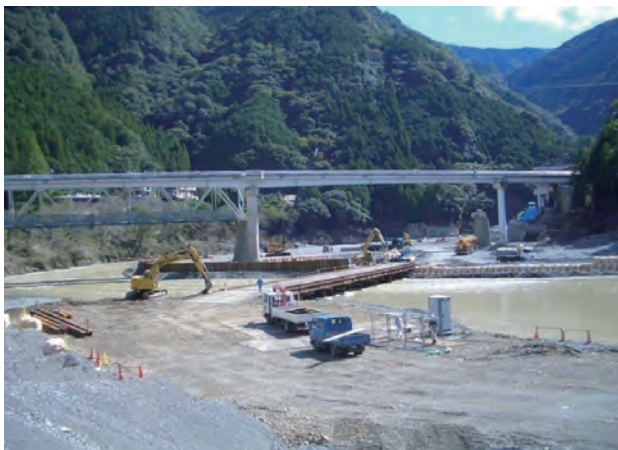
工事用道路の完成(10月6日)
