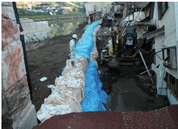
高岡地区応急対応工事(9月7日)
