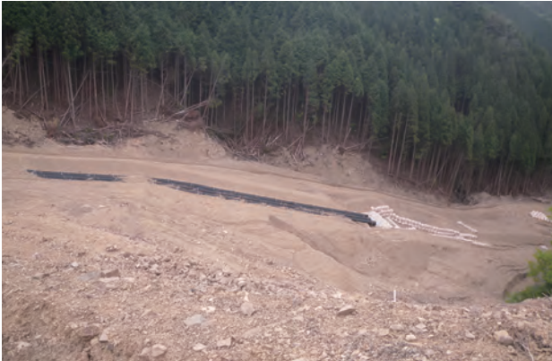
仮排水路整備中(24年5月14日)
