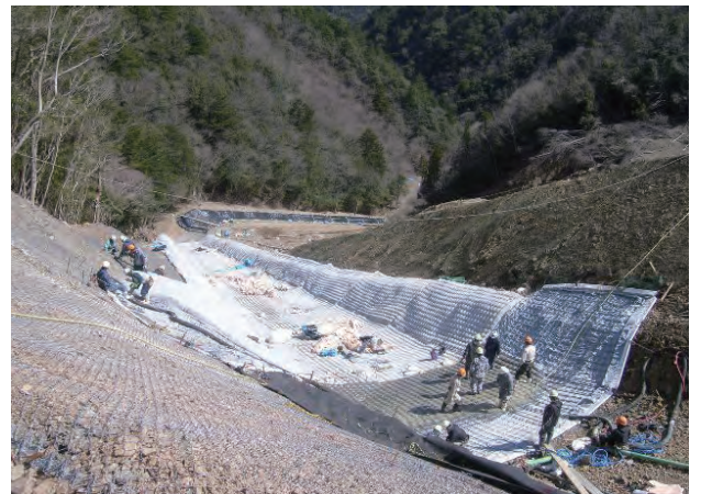
布製型枠水路の打設
