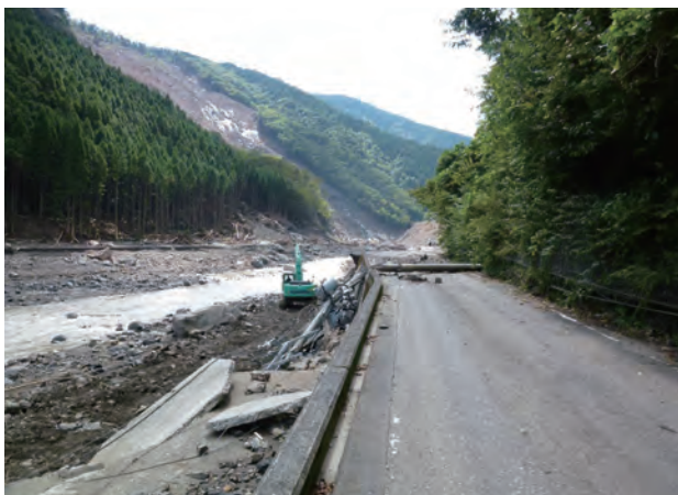
赤谷地区工事用道路整備状況(9月18日)
