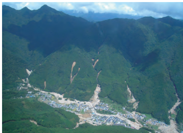
那智川流域の土石流被害
