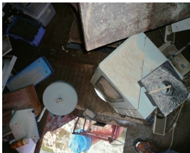
辻堂観測所の水位記録計(泥を被る)
