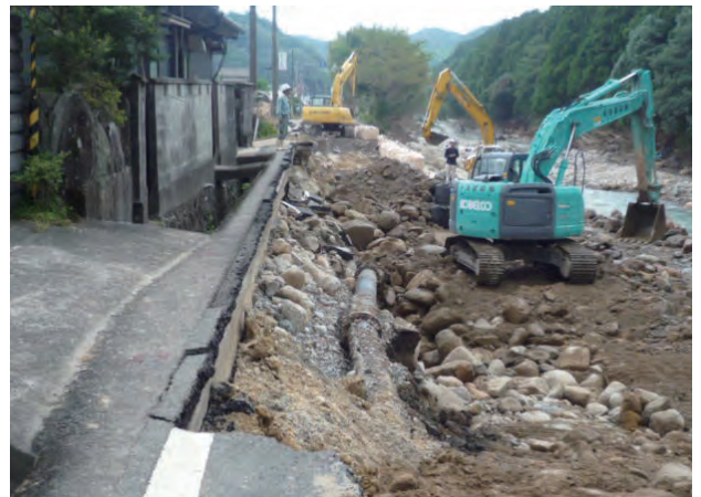
県道那智山勝浦線の応急復旧(9月9日)
