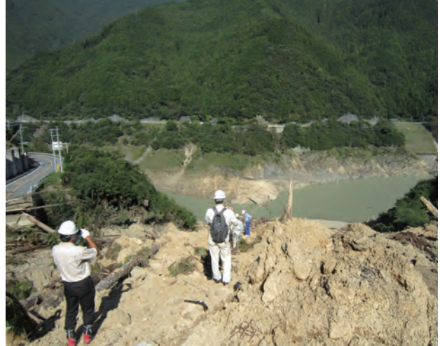
国道169号西谷橋(9月27日)
