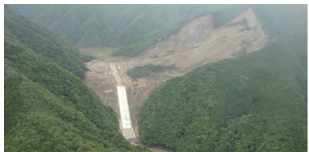
越流時の仮排水路(24年6月20日)
