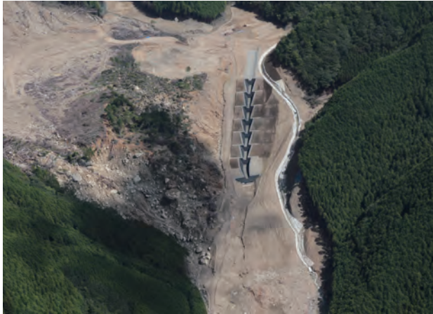
排水路整備中(24年10月1日)
