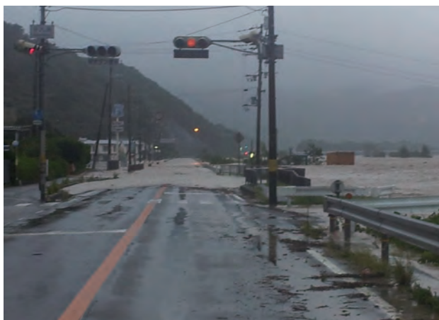
路面冠水(9月4日7時頃)北側から
