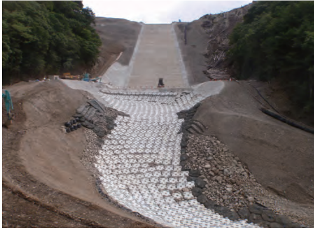
仮排水路の流末(24年8月24日)
