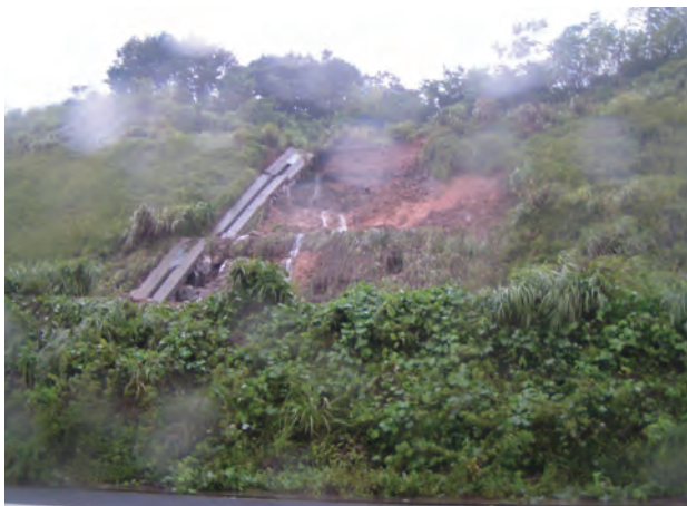
国道42号那智勝浦道路(9月4日)
