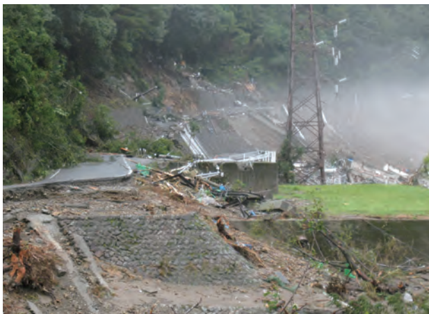
国道168号長殿発電所付近(9月4日、十津川村提供)
