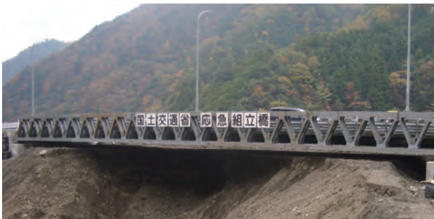
応急組立橋の架設(11月17日)
