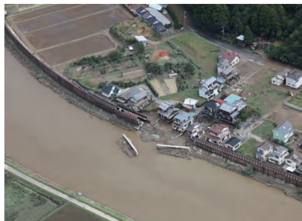
②高岡地区の輪中堤の倒壊(9月5日11時頃)
