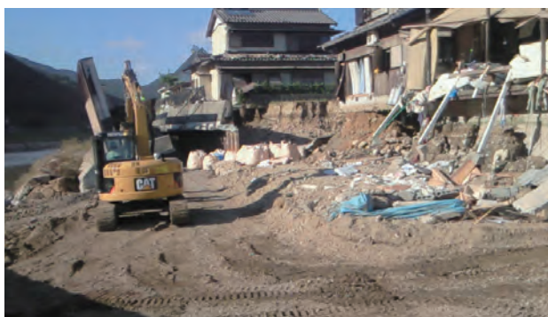
高岡地区応急対策工事(9月6日)
