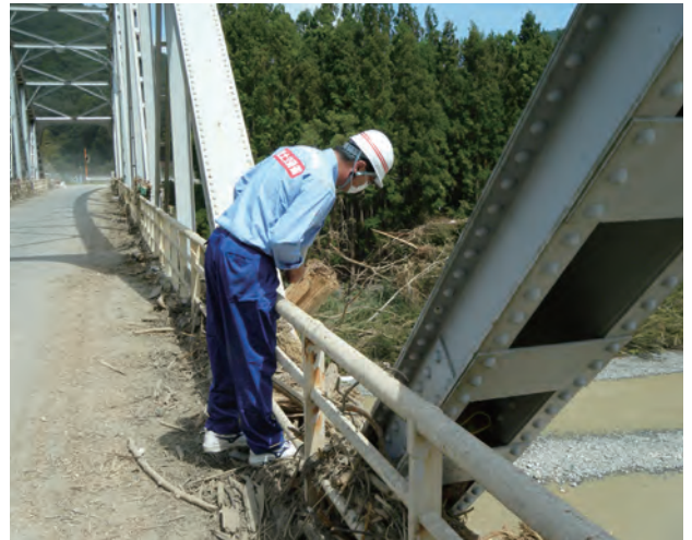
国道169号宮井橋(9月9日)
