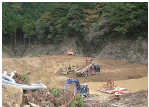
湛水池の埋め戻し(11月10日)
