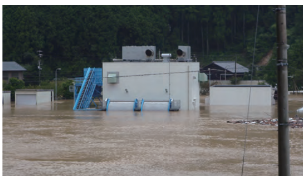
①相野谷川排水機場の浸水(9月4日11時頃)
