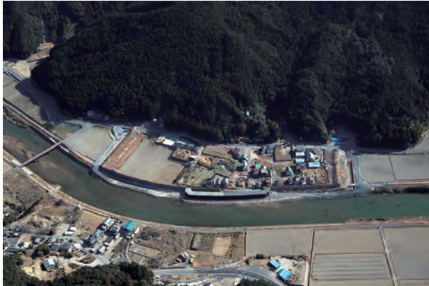
緊急復旧後(24年2月4日)
