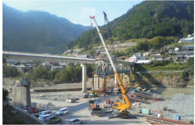
栈橋架設(10月8日)
