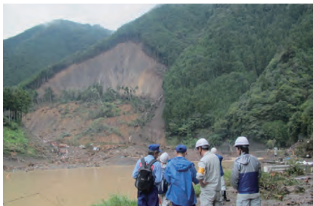
五條市大塔町宇井の斜面崩壊
