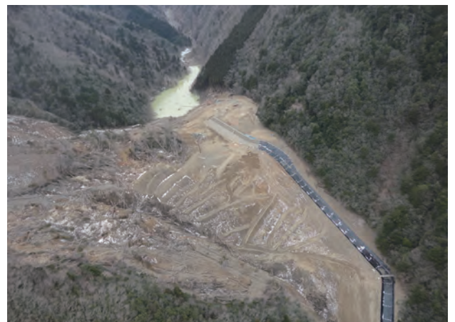
仮排水路施工中(24年2月21日)
