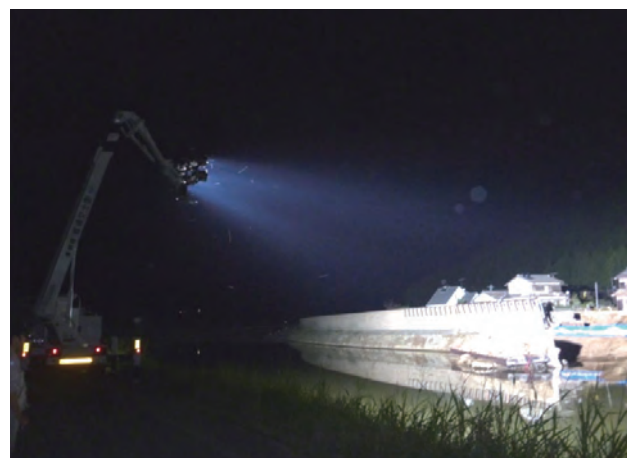
高岡地区での夜間作業を支える照明車(9月8日)
