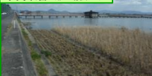
水質改善（植生護岸工）
