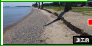
湖岸保全（砂浜浸食対策：養浜）
