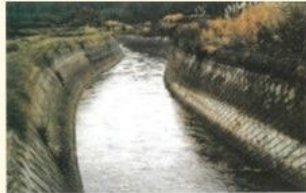
写真1-2-1 コンクリート護岸の事例
