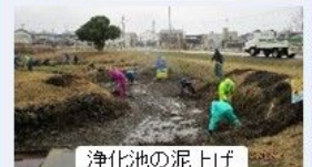
浄化池の泥上げ
