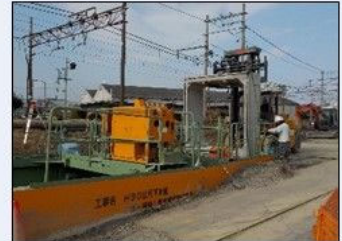
雨水整備工事の実施
