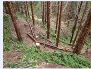
【保安林整備：本数調整伐・筋工】
