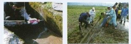
水路のひび割れ補修
