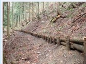
【保安林整備：本数調整伐・筋工】
