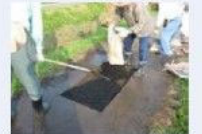
農道の部分補修
