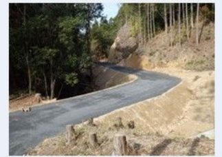
【森林整備：林道(整備)】
