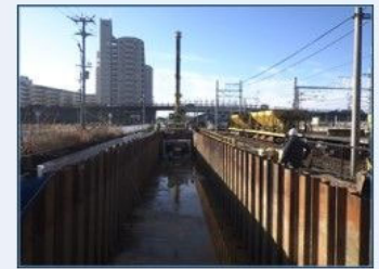
雨水BOXカルバート設置
