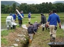
写真 堰上げ式魚道の設置の様子 (高島市マキノ町知内 R3.5.23)
