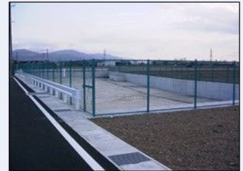
民間開発による雨水貯留施設設置
