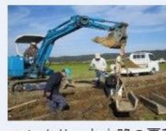
コンクリート水路の更新
