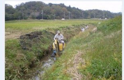
水路の泥上げ
