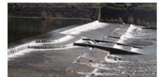
天野川岩盤地先 本格魚道
