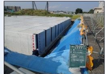
公共事業による雨水貯留施設設置
