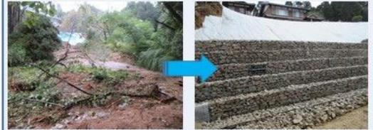
人家の保全 (鋼製土留擁壁工・法面植生工)
