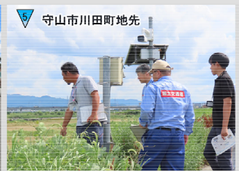
危機管理型水位計・簡易型河川監視カメラの設置位置や運用状況について説明・確認
