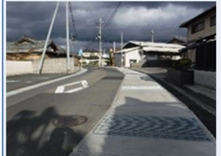
雨水対策で改良された水路
