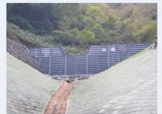
【治山：溪間工(治山ダム)】
