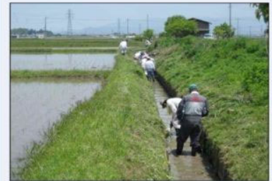
水路の泥上げ
