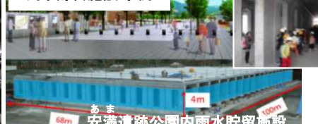
雨水貯留施設 事例
