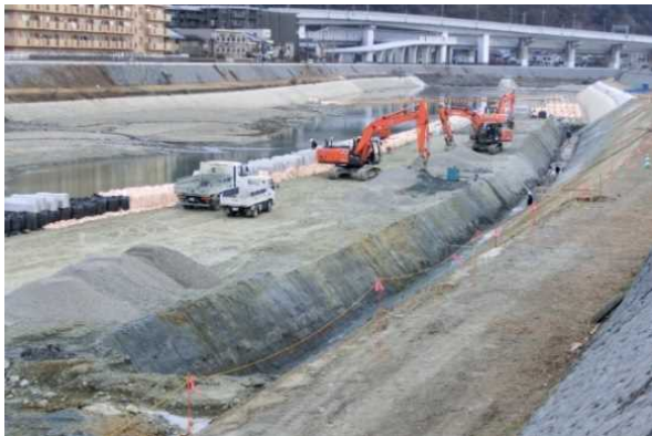
出在家地区河道掘削(国土交通省)
