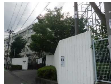
浸水深4.6m第四小学校正門
