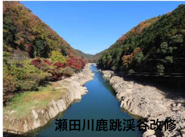
河川改修・維持管理
