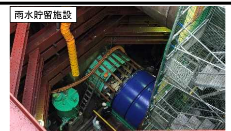
直径2.4m、延長550mの雨水貯留管整備の掘削立坑(池田市)
