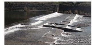
天野川岩盤地先 本格魚道
