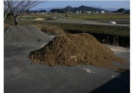
山砂等の資材支給
