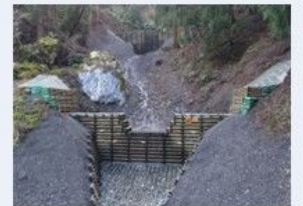
【治山：溪間工(治山ダム)】
