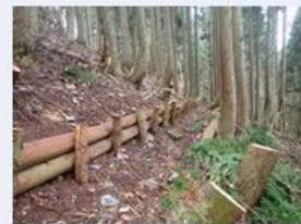
【保安林整備：本数調整伐・筋工】
