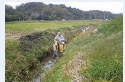
水路の泥上げ
