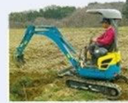
農家による簡易整備
