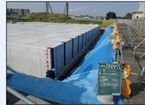
公共事業による雨水貯留施設設置
