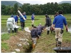
写真 坂上げ式魚道の設置の様子 (高島市マキノ町知内 R3.5.23)
