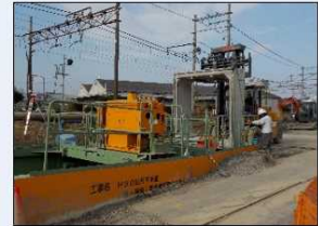
雨水整備工事の実施
