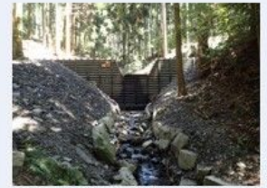
【治山：溪間工(治山ダム)】
