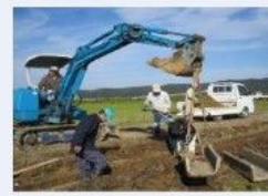
コンクリート水路の更新
