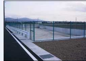
民間開発による雨水貯留施設設置
