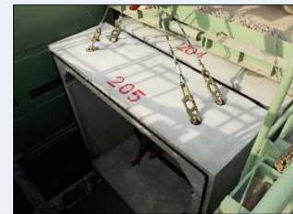
雨水BOXカルバート設置
