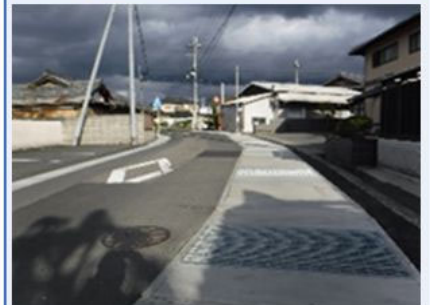
雨水対策で改良された水路
