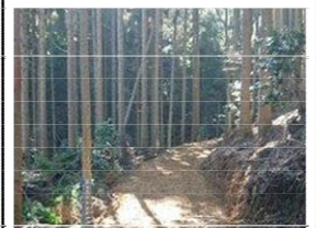
路網(作業道)整備状況
