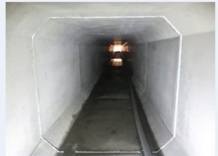
・雨水渠整備状況(殿田川) (ボックスカルバート 口1200)
