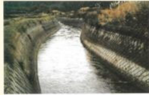
写真1-2-1 コンクリート護岸の事例
