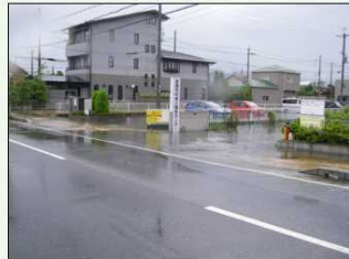
整備前の庄堺公園周辺の浸水状況
