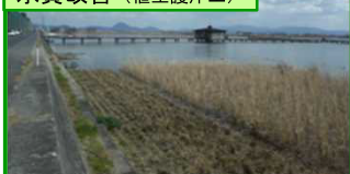
水質改善（植生護岸工）
