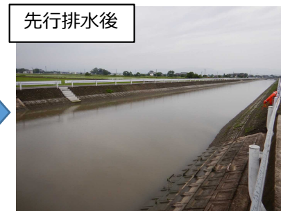
農業水利施設の整備・有効活用(クリーク)の活用 【筑後川水系】
