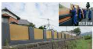
自主防災活動による曇堤設置 (掃保川水系、たつの市)
