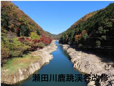
河川改修・維持管理
