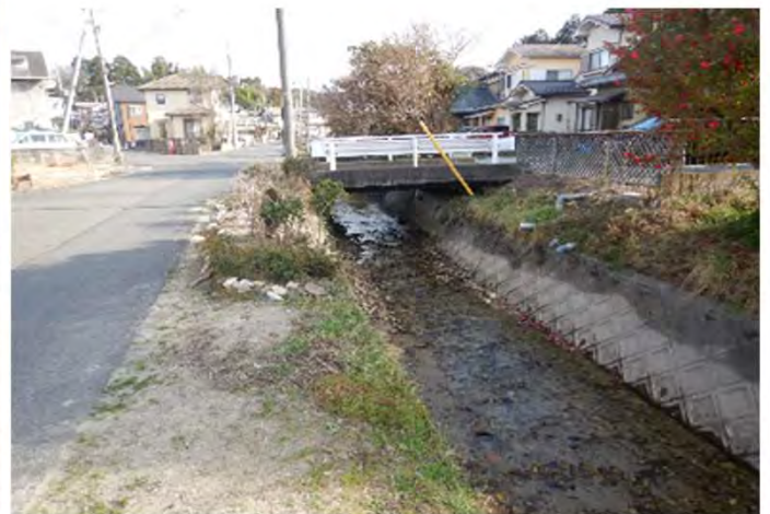
落合川 堆積土砂撤去後 既設護岸状況確認
