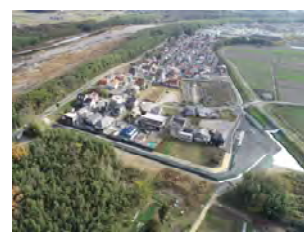
輪中堤防の築堤
