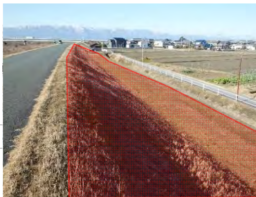
新庄地区 法尻補強工事 右岸4.0k付近～4.8k付近
