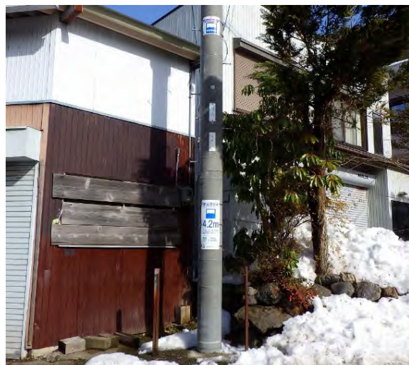
地点①の設置状況
