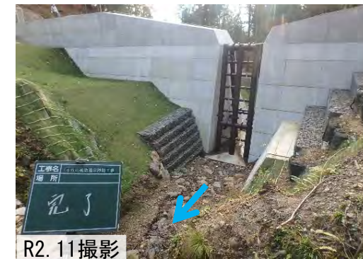
⑥本谷川【砂防堰堤】実施済み
