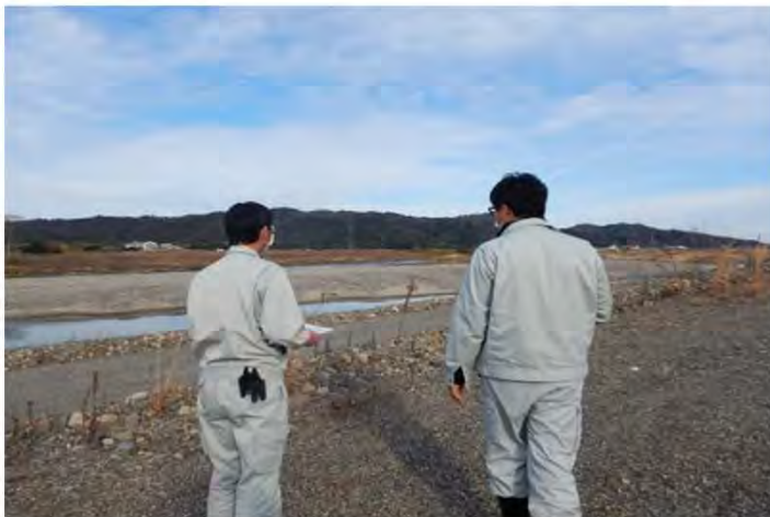
野洲川既設護岸 状況確認
