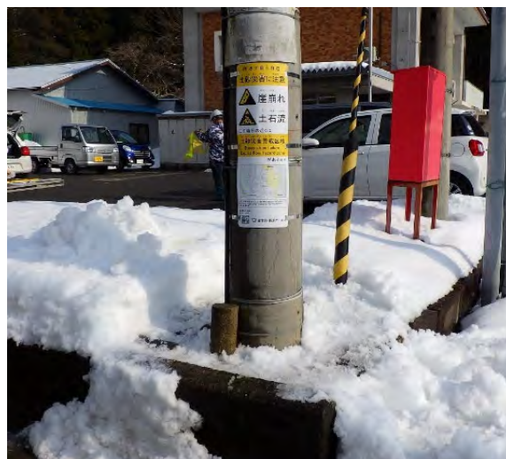
地点④の設置状況
