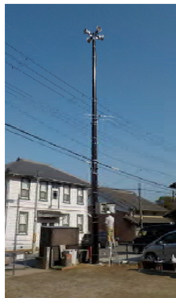
同報系屋外放送設備 写真
