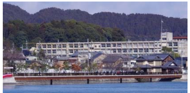
完成した南郷ほたる橋
