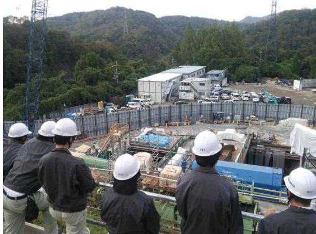
工事現場を見学している様子（ゲート室部）
