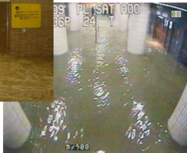
台風22号(平成16年10月)による麻布十番駅の浸水
