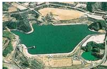
ダムの建設(白川ダム)
