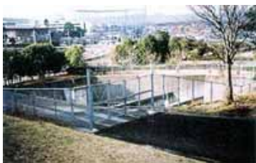
防災調整池の設置
