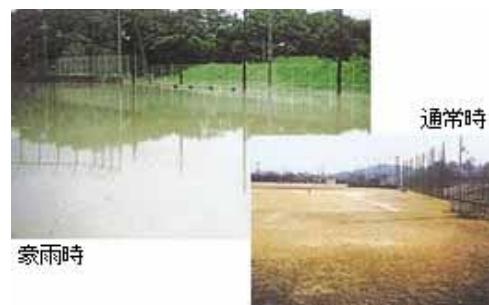
グラウンド等を利用した雨水貯留浸透施設の設置
