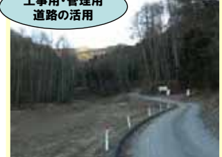
砂防堰堤工事により設置した工事用道路は間伐材の搬出等に活用。
