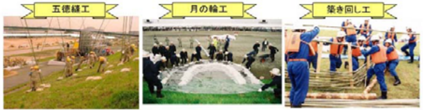
出典:国土交通省(水防の基礎知識)
