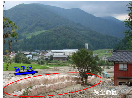
大型土のうの設置状況(土沢地区) [平成23年8月9日設置完了]
