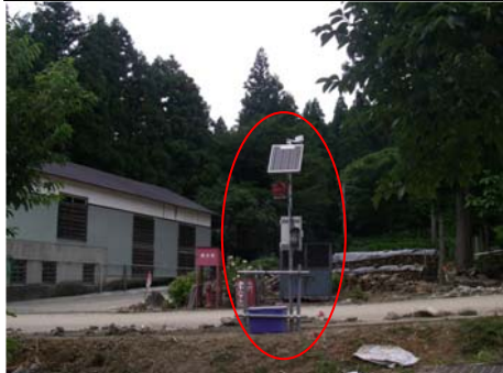
警報装置の設置状況(小川地区) [平成23年8月3日設置完了]
