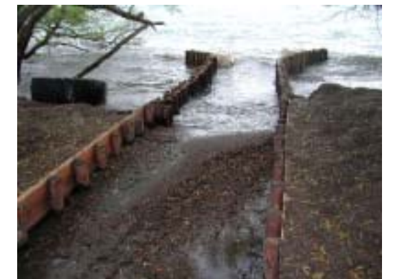
図 2 深溝地区 水路の通水・閉塞状況
