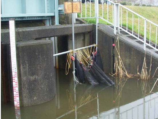
降下トラップ設置状況
