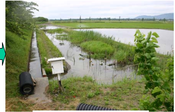
施工後1年3ヶ月 (H18.6.9)
