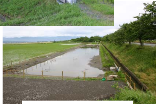
施工後3ヶ月 (H18.6.9)
