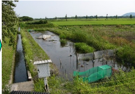
施工後4ヶ月 (H17.7.23)
