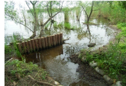
連絡部の漂砂防止堤 (平成19年3月に設置)
