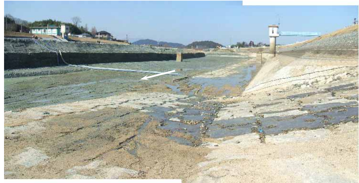
全景写真(中流を望む)
