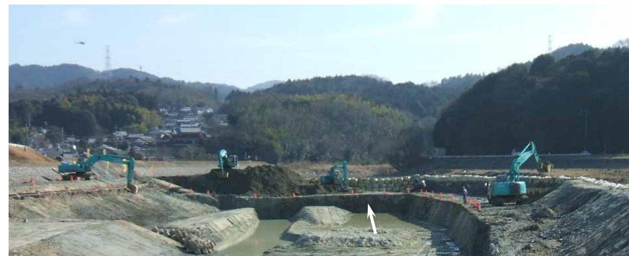
全景写真(下流を望む)
