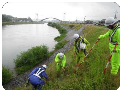
▲堤防点検の様子
