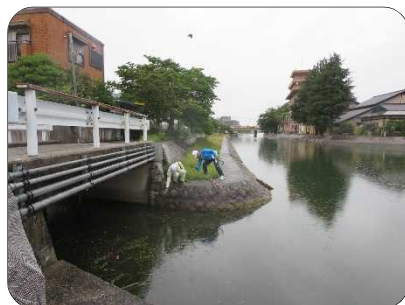
▲護岸点検の様子
