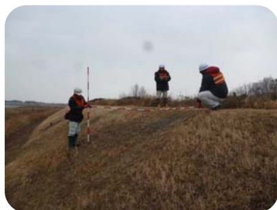
▲堤防点検の様子
