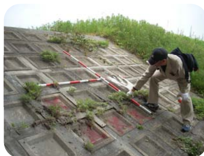
▲護岸点検の様子
