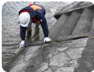
▲護岸点検の様子
