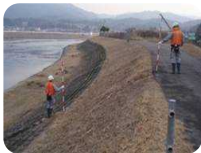
▲堤防点検の様子
