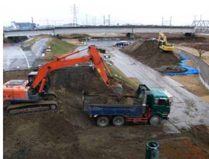
▲ 堤防開削の状況
