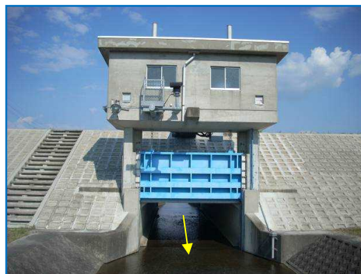
▲ 矢田樋門の全景
