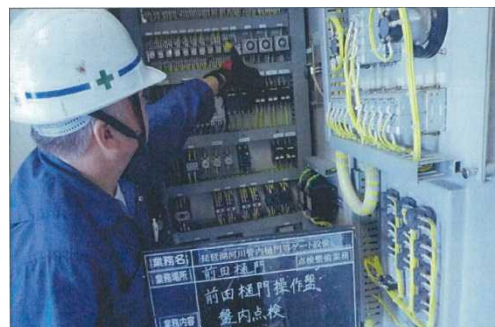
▲ 前田樋門の点検状況
