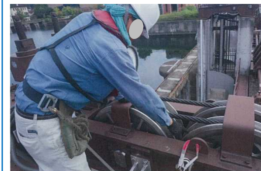
▲ 瀬田川洗堰の点検状況
