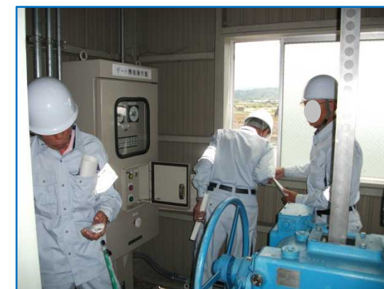
▲ ゲート操作の実地訓練状況
