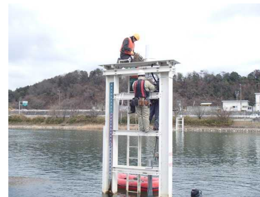
▲ 橋本流量観測施設(更新作業状況)
