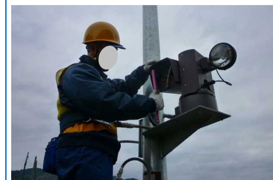
▲ 電気通信施設の点検状況
