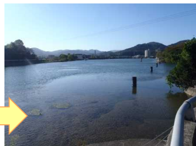
▲ 土砂撤去後の状況
